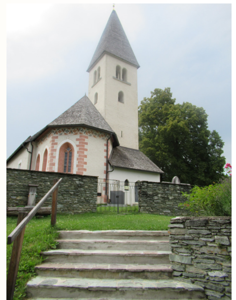
Die sanierte Treppe zur Pfarrkirche St. Paul.
