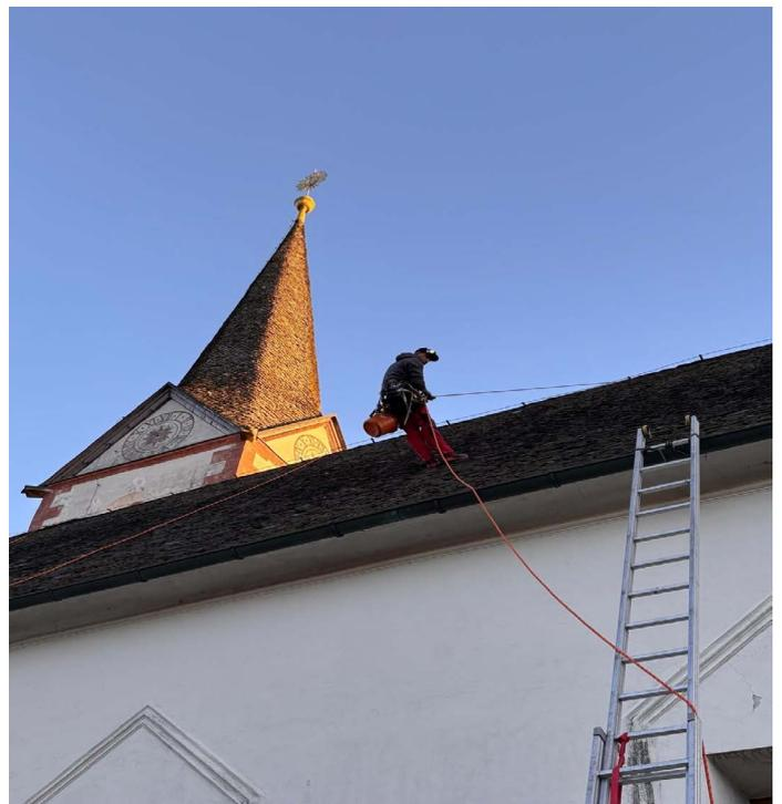
Im Sommer 2024 gingen bei einem Sturmschaden etliche Steinschindeln kaputt. Die Reparatur des Daches ist abgeschlossen, die Malerarbeiten im Innenraum erfolgen bis spätestens Herbst 2025.
