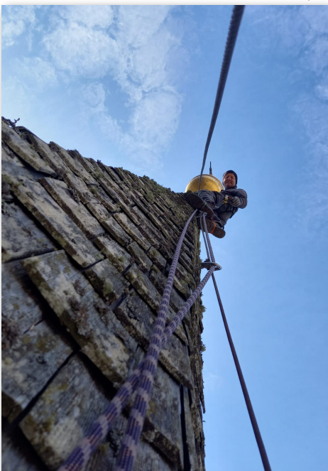
Kirchturmreparatur durch die Firma Mayerl
